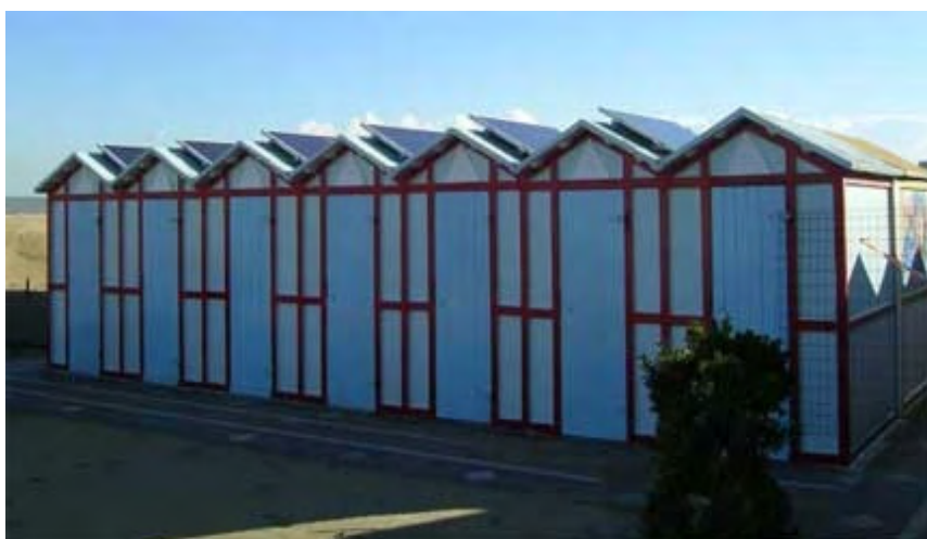
Esempio: inserimento pannelli in copertura esistente.
